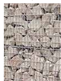
SOCLE EN GABIONS
